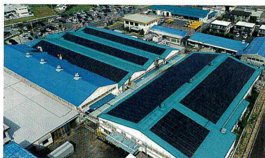
ハンファQセルズジャパンの設置事例。協栄製作所向けでパネル容量は485.64kW
