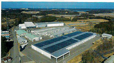
北陸電力による福井鉄線組木事業所向けの設置事例。福井鉄線は30年度に二酸化炭素排出量30%削減(13年度比)を掲げる
